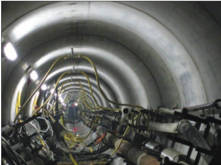
(d) The tunnelling, laser, transport lines and supply lines.
