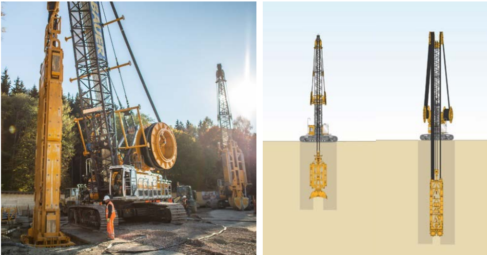
Abb. 1: Arbeiten am Damm Roßhaupten (Deutschland), ausgeführt mit einem Schlitzwandgreifer (Mitte) und einer Schlitzwandfräse (im linken Foto links und ganz rechts).
